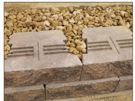
Diagram 8—Backfill and Fill Voids
